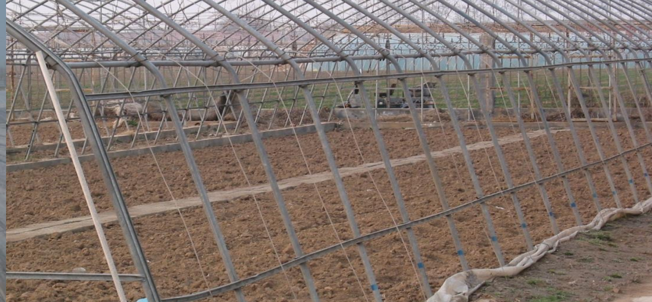
单栋大棚的骨架结构
